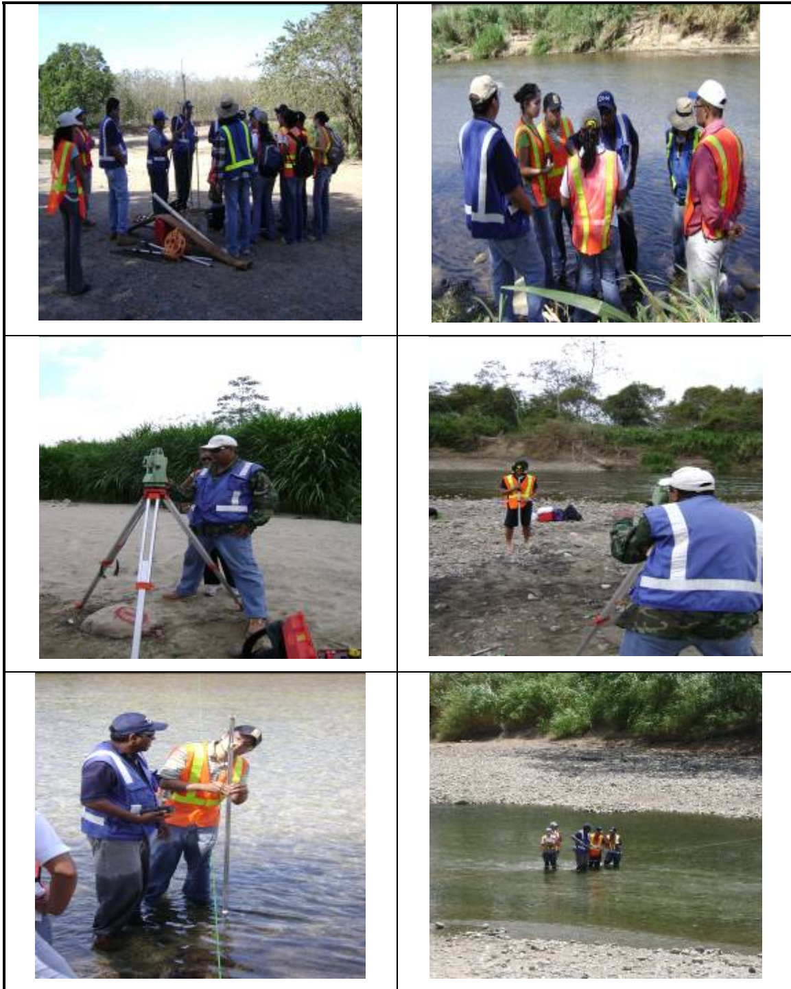
Fig. 6. Diferentes vistas del aforo y levantamiento topográfico en diversas secciones del río Pacora
