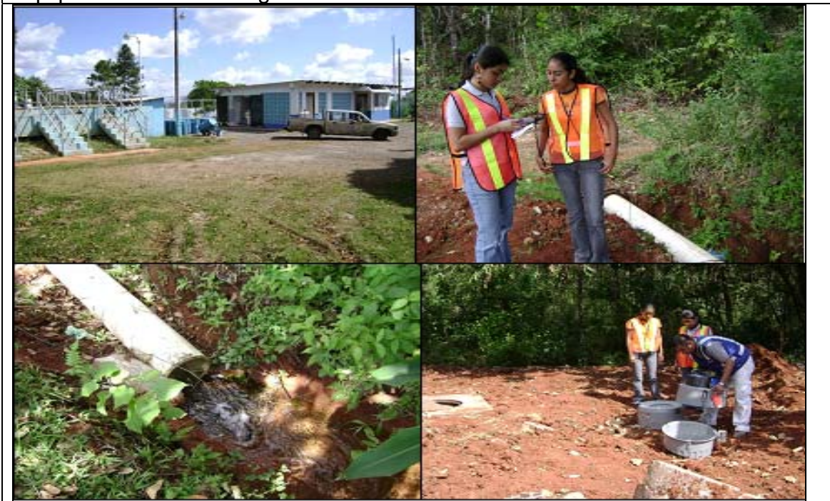
Fig. 5. Estudiantes de Tesis y Personal del C.I.H.H. realizando la instalación del equipo Muestreador en la Planta Potabilizadora de Cabra.
